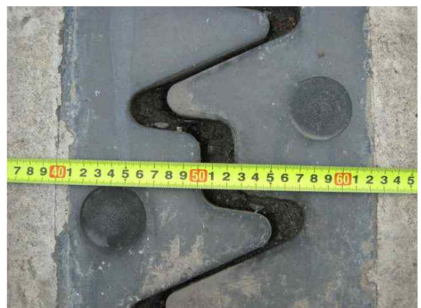
신축이음 이동량 측정
